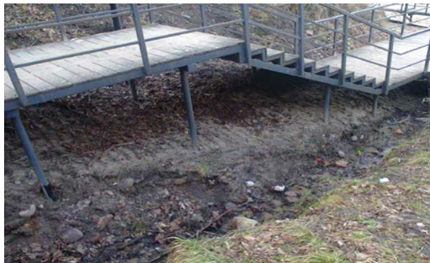
Рис. 1. Размыв берега вблизи обустроенного спуска. Фото автора
